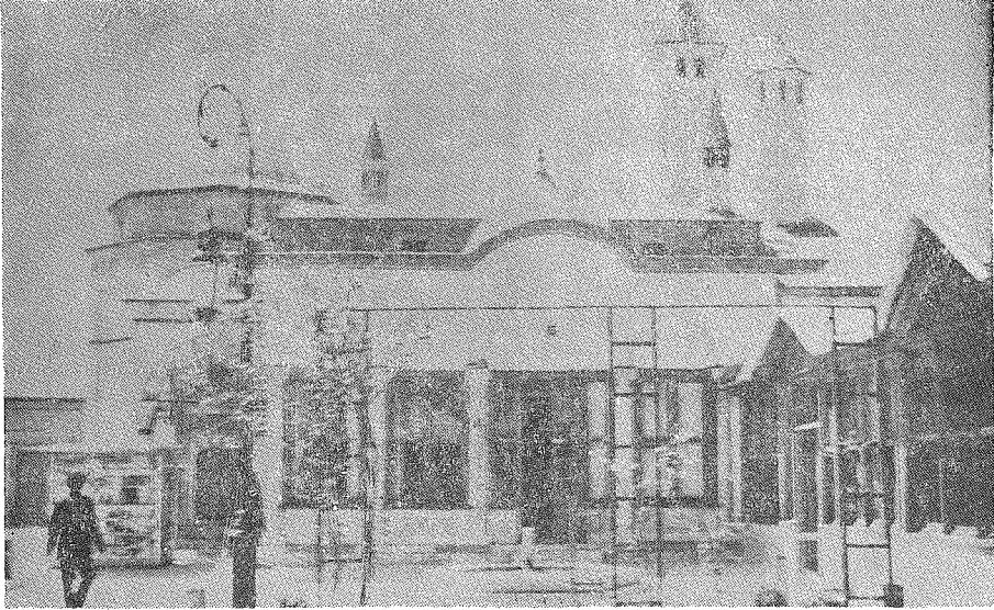
Resim 6. Konya Mevîânâ Dergâhı Matbah-ı Şerifi girişindeki revak kısmı.
