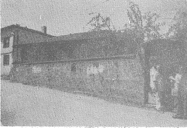
RESİM 1 - Briket bahçe duvarının arkasında semâhane, sağında 19 no.lu giriş kapısı
